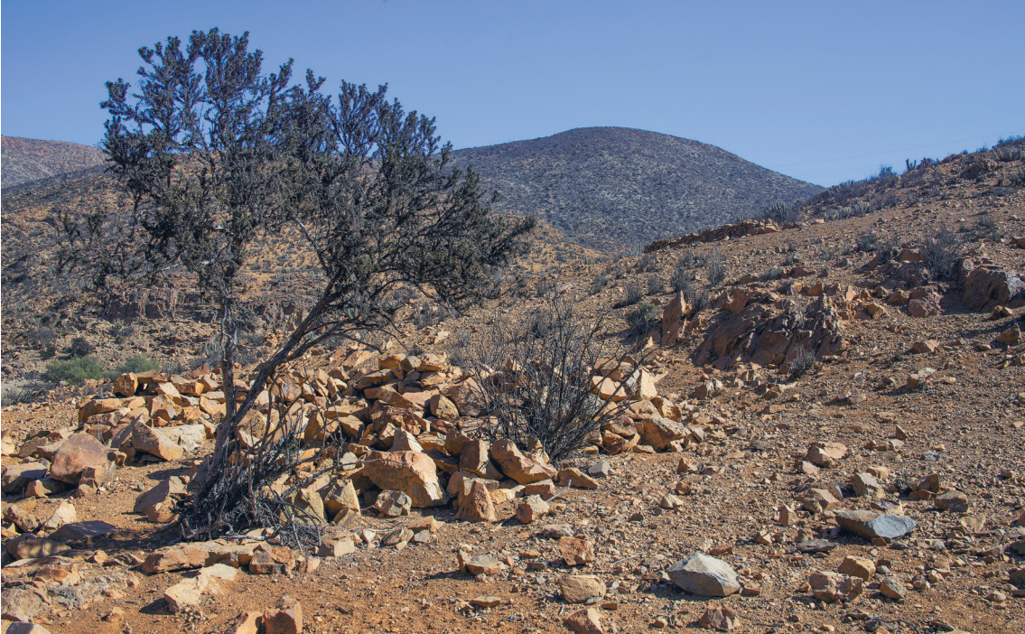
Estructura habitacional Molle derruida en el sector de Aguadita.
